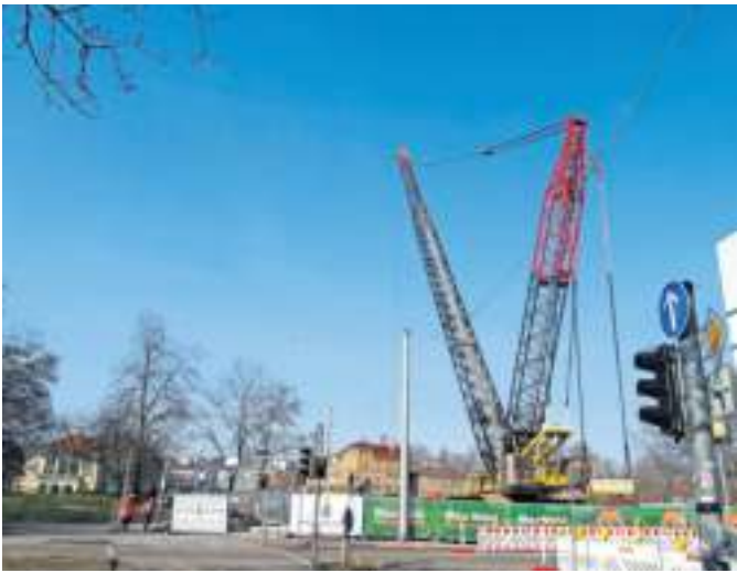
Mit einem Gewicht von 1000 Tonnen kann der Kran bis zu 500 Tonnen schwere Objekte bewegen.
