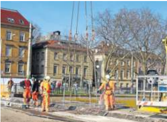
Um die einzelnen Segmente der Brücke ausheben zu können, müssen Löcher hineingebohrt werden, und die Stahlketten des Krans werden durchgefädelt.
