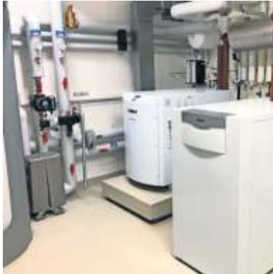
Blockheizkraftwerk in einer Wohnanl
