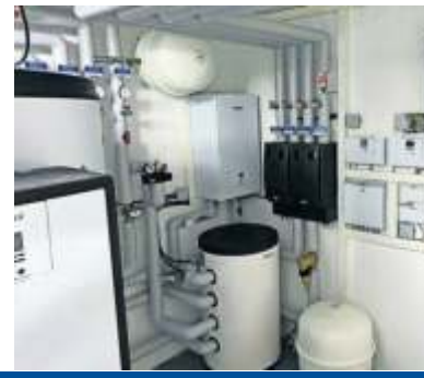
Blockheizkraftwerk in einer Wohnanl
