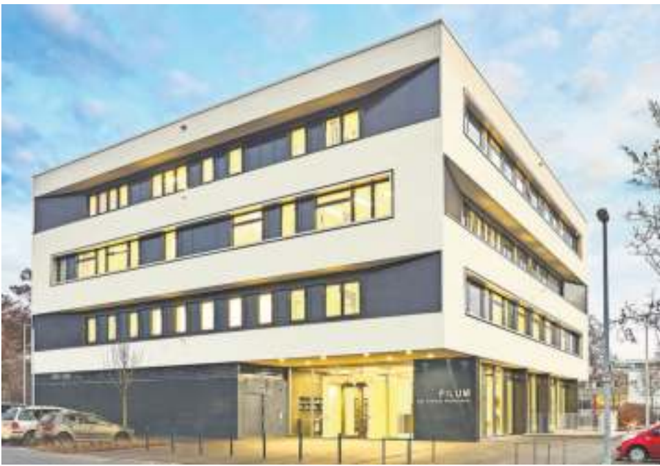
Ein markanter Bau: das Filum-Musikschulgebäude.
