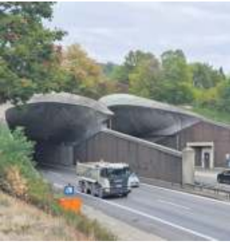
Der Kappelbergtunnel an der B14 zwischen Fellbach und Stuttgart erhält einen Rettungsstollen. Foto: Dirk Herrmann
