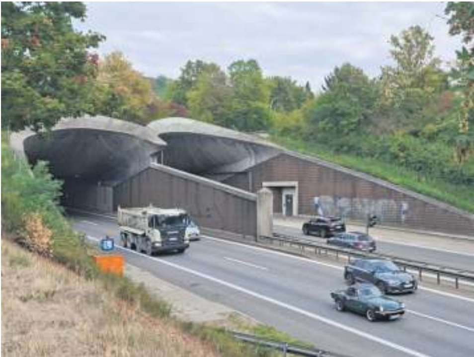
Der Kappelbergtunnel an der B14 zwischen Fellbach und Stuttgart erhält einen Rettungsstollen. Foto: Dirk Herrmann
