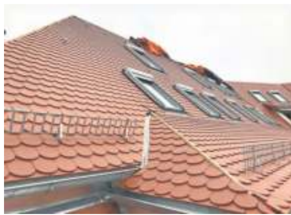
Komplexe Dachkonstruktion mit Dachfenstern.
