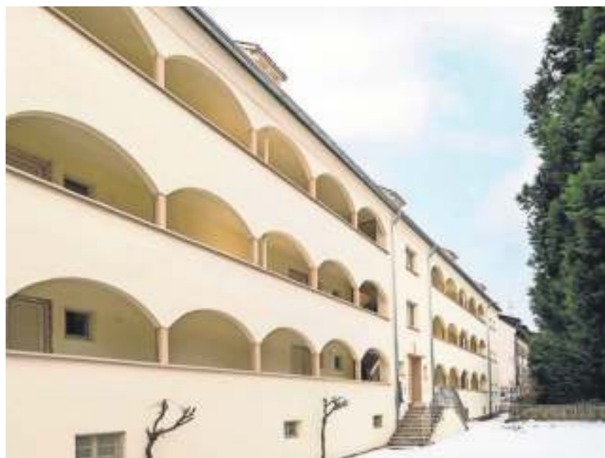
Das Gebäude in der Endersbacher Straße wurde saniert.
