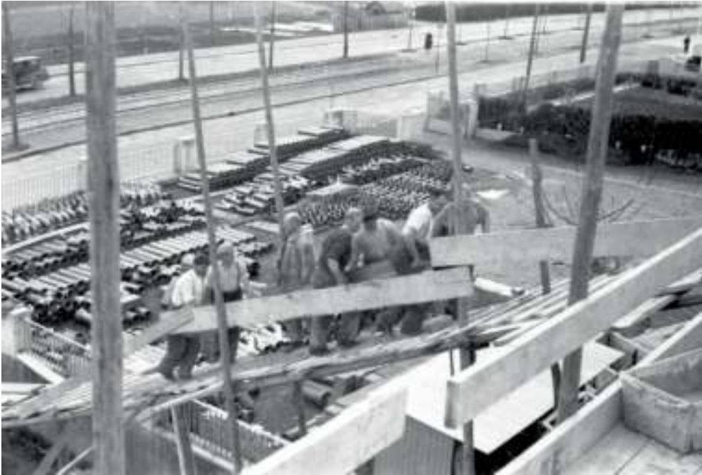
Harte Arbeit beim Einbau von Deckenbalken
