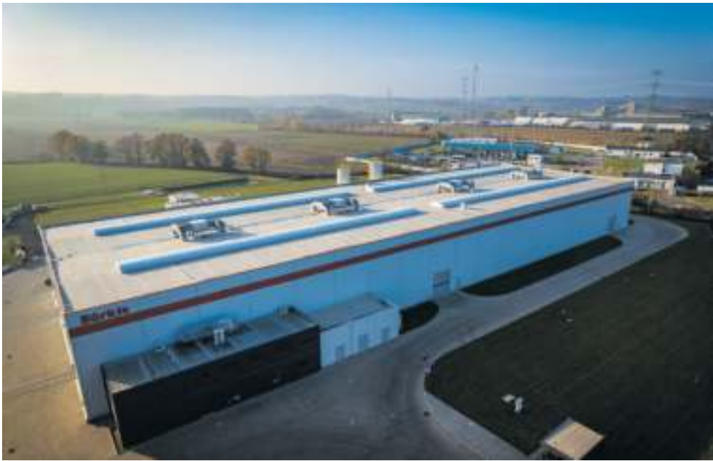
Die neue Produktionshalle in Rakowice
