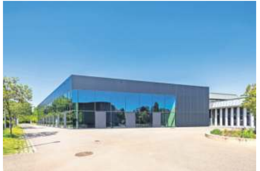
2006 entstand der Anbau.
