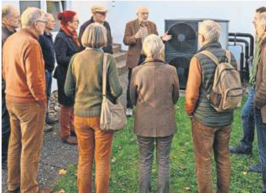
Hausbesitzer teilen beim Wärmepumpen-Spaziergang ihre Erfahrungen mit der Wärmepumpe. Foto: Energieberatung Rems-Murr
