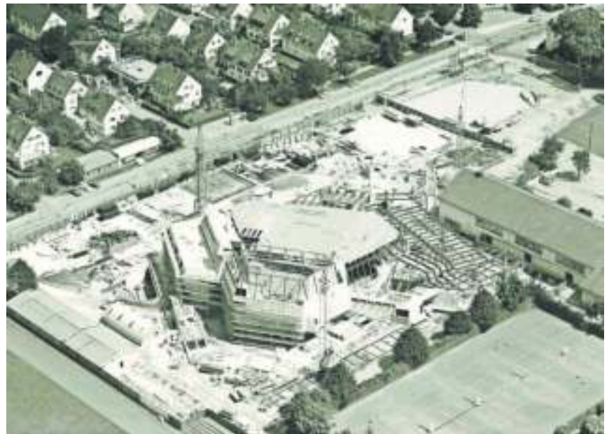
Die Schwabenlandhalle im Bau.
