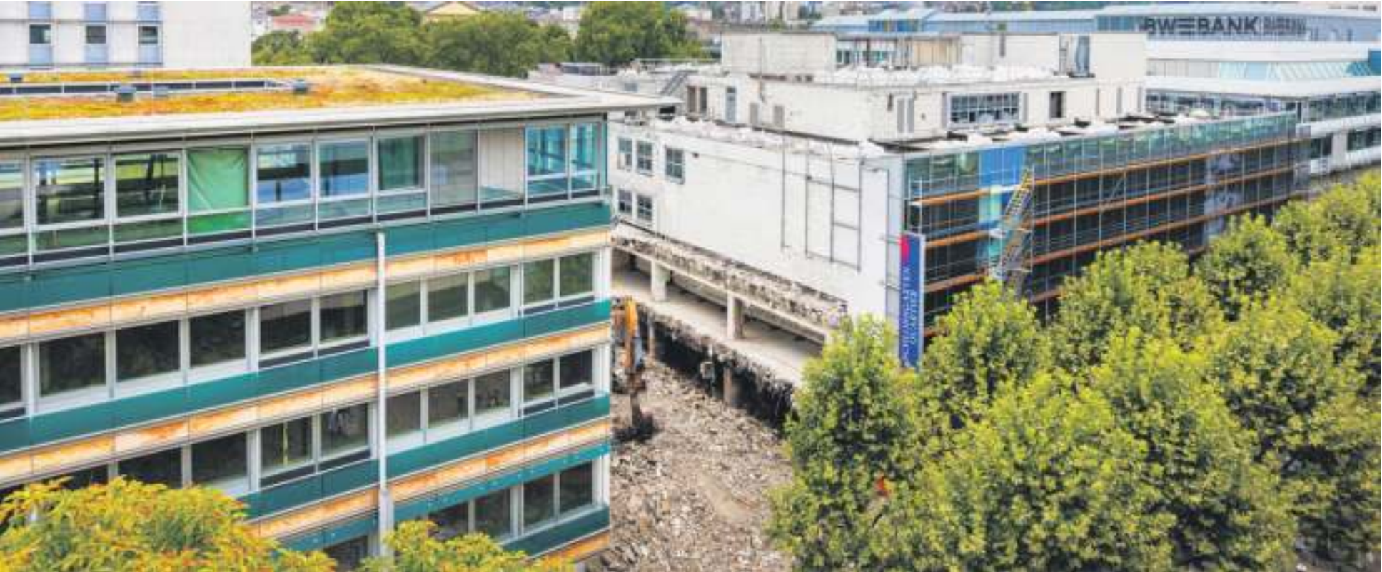
Die alte überdachte Theaterpassage an der Unteren Königstraße ist Geschichte – Bagger haben sie abgerissen.
