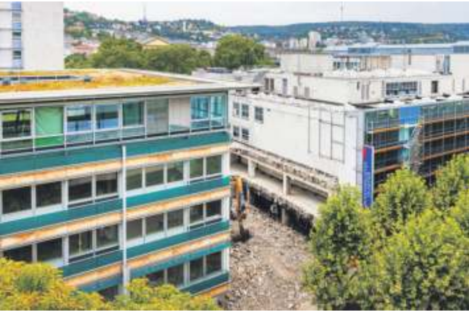
Die alte überdachte Theaterpassage an der Unteren Königstraße ist Geschichte – Bagger haben sie abgerissen. Foto: LBBW Immobilien/Lukas Frontzek
