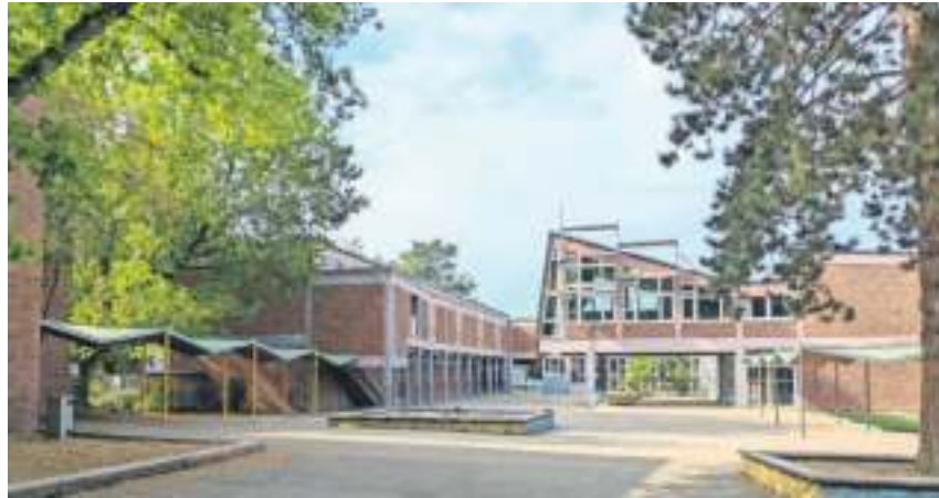
In der alten Maicklerschule steht eine Dachsanierung an.
