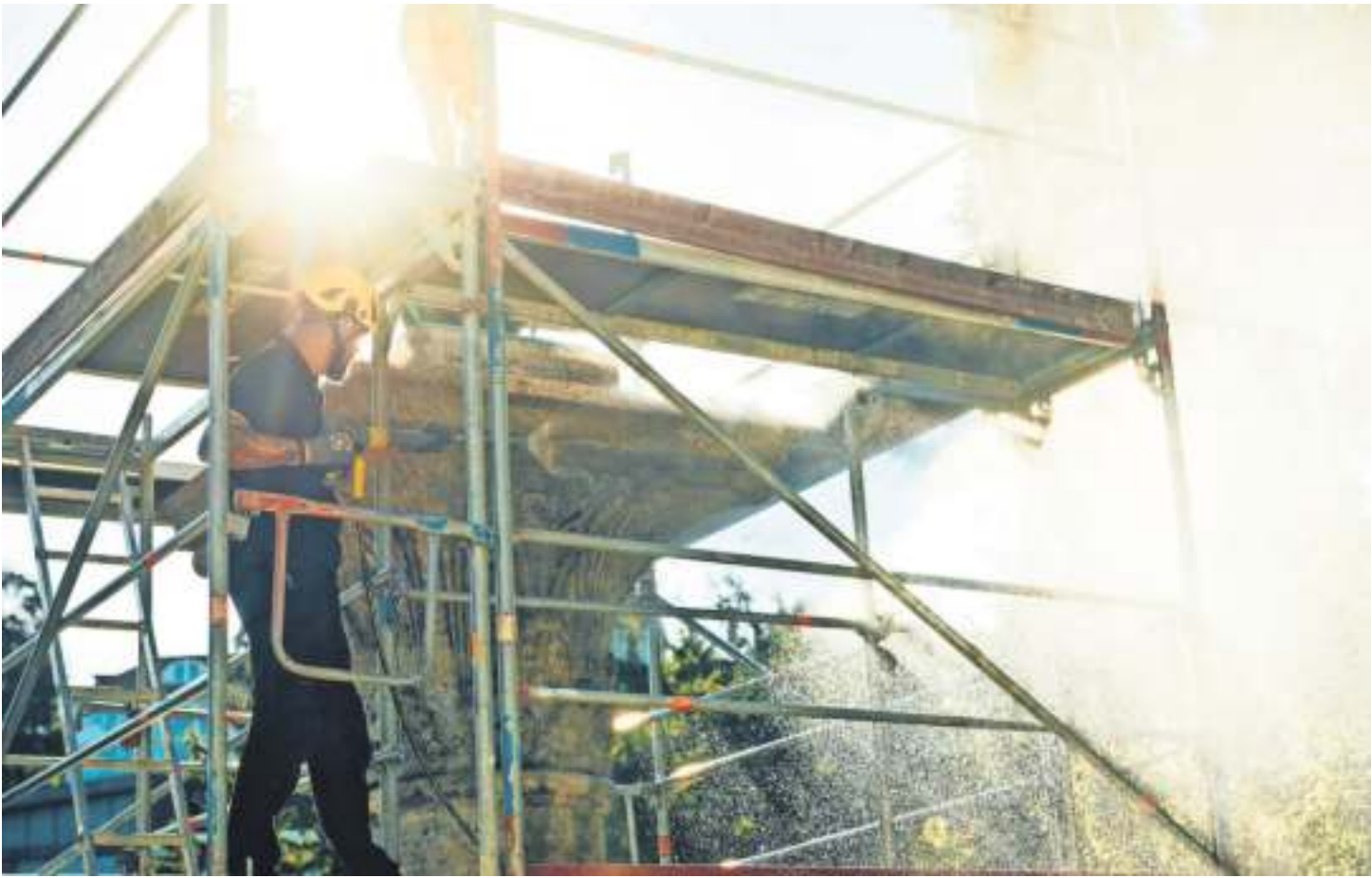
Dem Bewuchs an der Fassade des Marmorsaals ging es in einer zweiwöchigen Aktion an den Kragen. Im Rahmen des Kultursponsorings der Firma Kärcher wird die Fassade des Marmorsaals inklusive Frühlingssäule und Treppenanlage aufwendig gereinigt.
