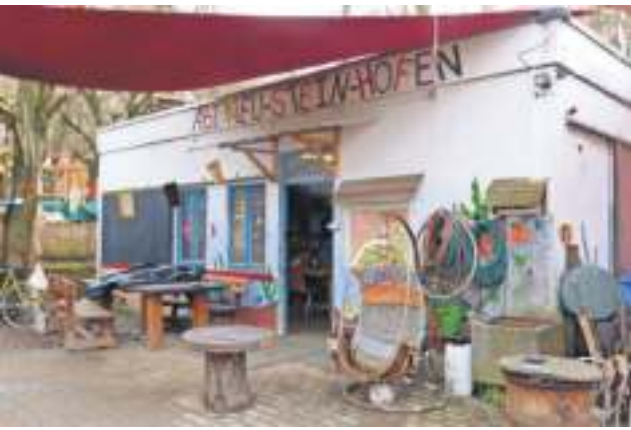
Das Kinderhaus auf dem Abenteuerspielplatz Neu-Stein-Hofen kann abgerissen und neu gebaut werden.
