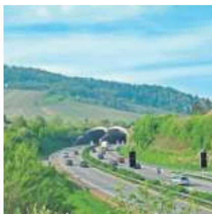
Ende August ist der Kappelbergtunnel gesperrt. Foto: Hartung
