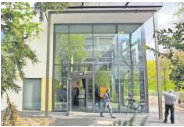
... die Werkrealschule Gablenberg ...
