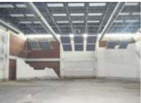
Derzeit steht von der Mehrzweckhalle nur noch die Außenhülle. Der Abriss wird teurer als erwartet.
