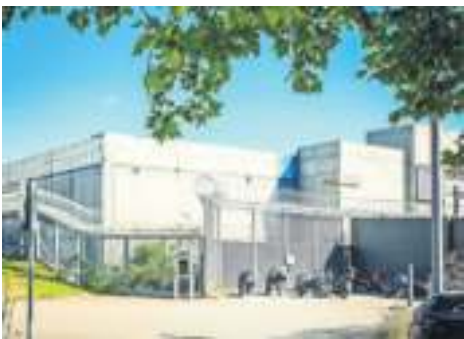
Das alte Gerichtsgebäude ist seit drei Jahren eine Baustelle. Wände und Decke sind noch unangetastet.
