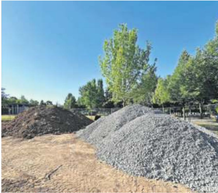
Die Bauarbeiten auf dem Kleinfeldfriedhof schreiten voran. Foto: Stadt Fellbach
