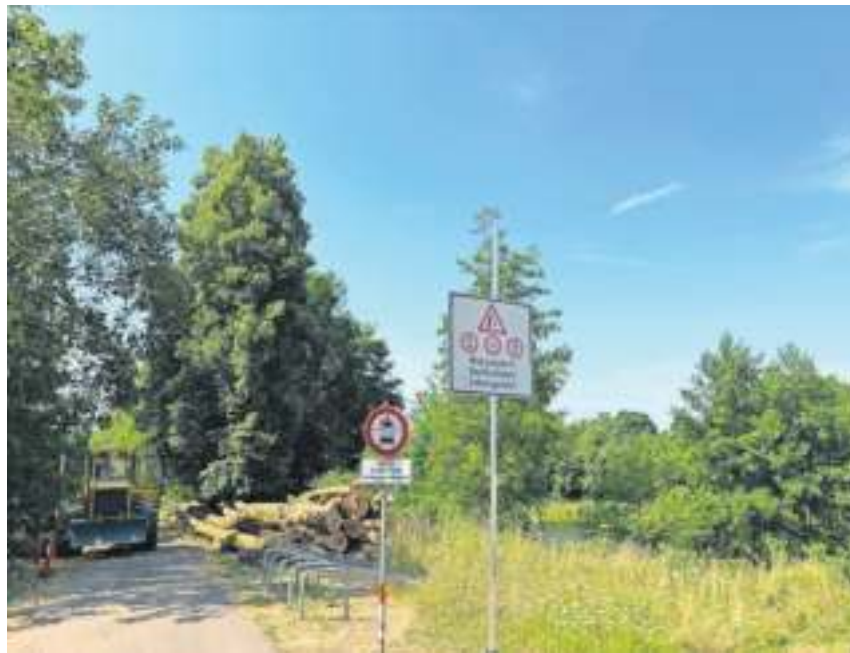
Die Baumfällarbeiten im Weidachtal sind beendet.
