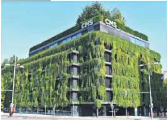
Die Begrünung des Green Building an der Calwer Passage in Stuttgart verhindert hohe Fassadentemperaturen und sorgt gleichzeitig für ein angenehmeres Raumklima.
