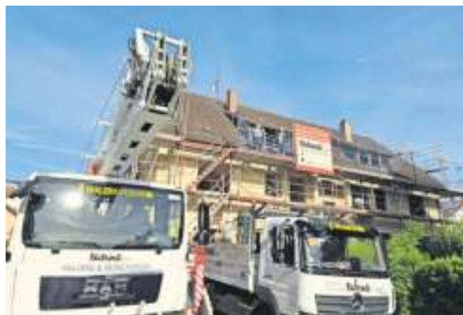
Altbausanierung mit Technik und Know-how.
