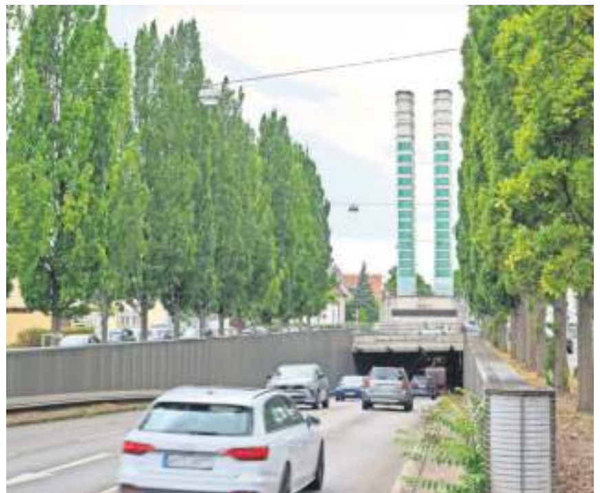
Der in die Jahre gekommene Stadttunnel wird saniert.
