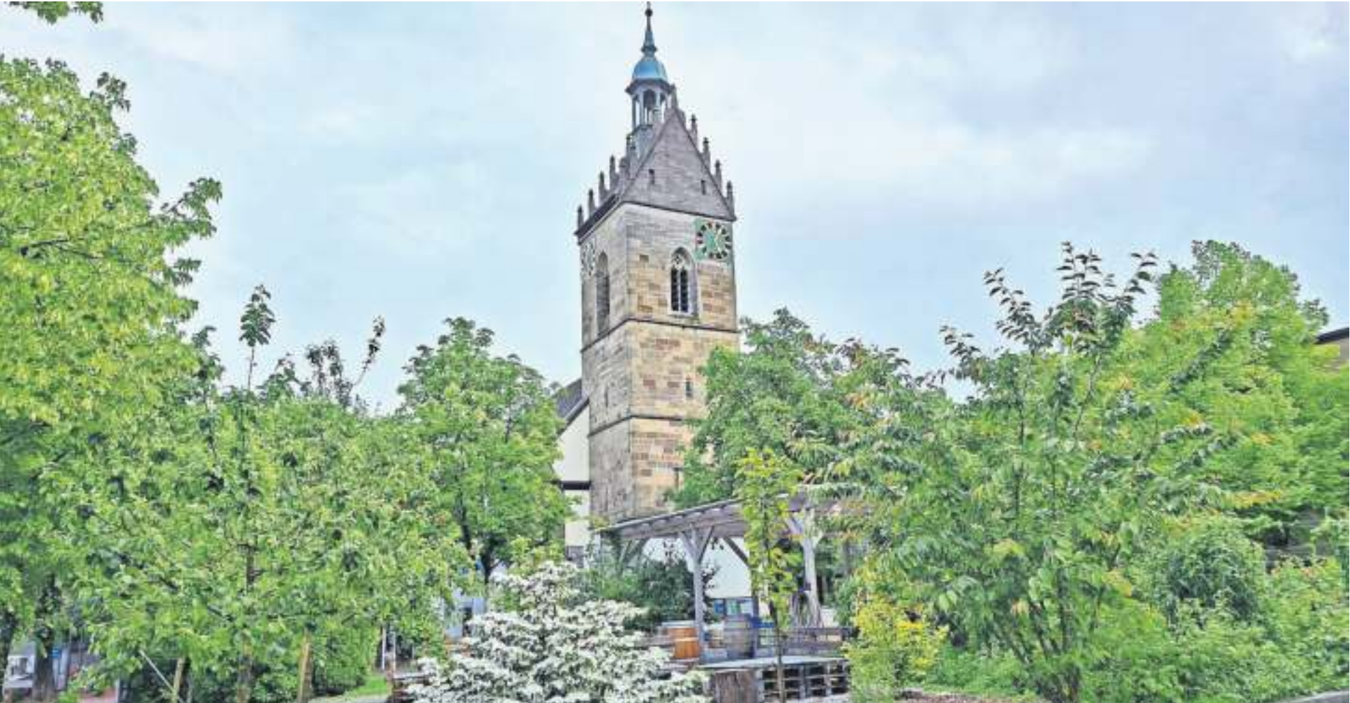
Der Turm der Fellbacher Lutherkirche muss eingerüstet werden.
