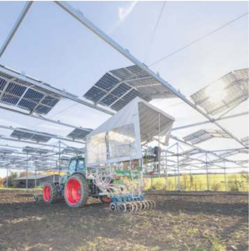
Unter der bis zu zehn Meter hohen Stelzenkonstruktion können branchenübliche Traktoren ohne Probleme hindurchfahren.
