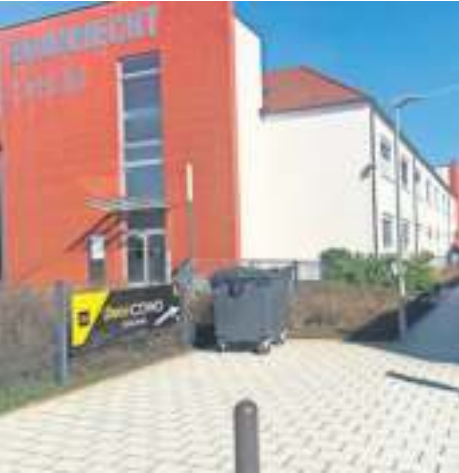
Moderne Lagerflächen stehen am Schmidener Weg 7 beim neuen store@COWO-Standort ab sofort zur Verfügung. Fotos: z
