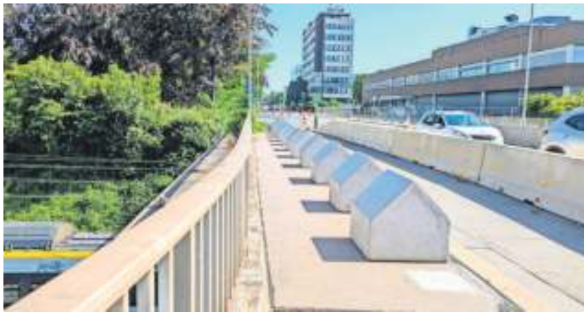
Die sanierungsbedürftige Brücke wird neu gebaut.
