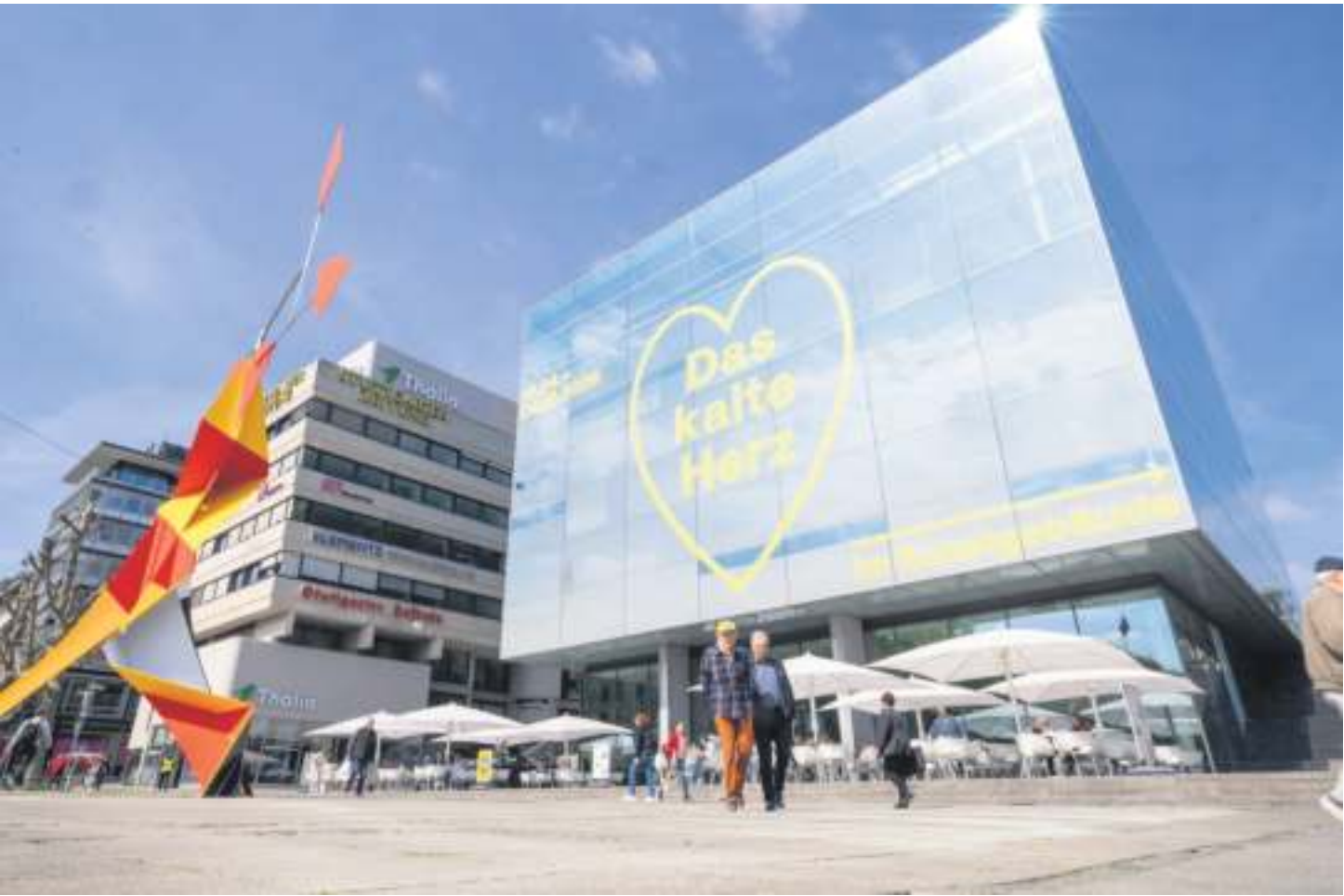
Das Kunstmuseum Stuttgart wird umfassend saniert – das Restaurant Cube und das Café im Erdgeschoss sind weiter geöffnet. Fotos: Lichtgut
