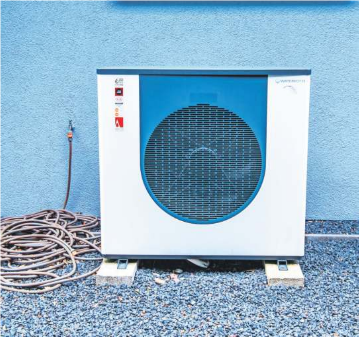
Moderne Wärmepumpen sind leiser als früher: Mit unter 50 Dezibel arbeiten sie so leise wie ein Geschirrspüler.
