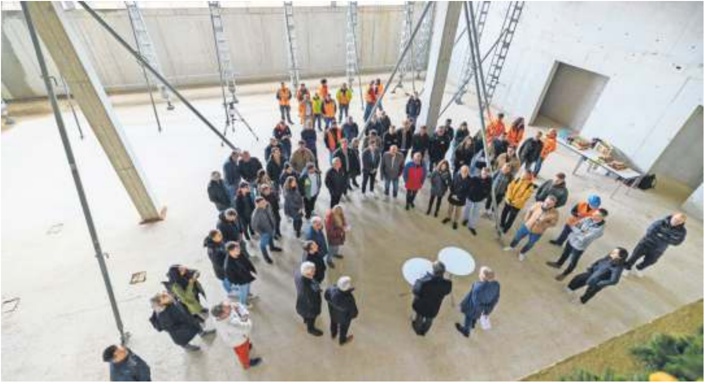
Bei einer Zusammenkunft wird der Abschluss der Rohbauarbeiten am neuen Sportzentrum Neckarpark gewürdigt. Foto: Leif Piechowski/Stadt Stuttgart
