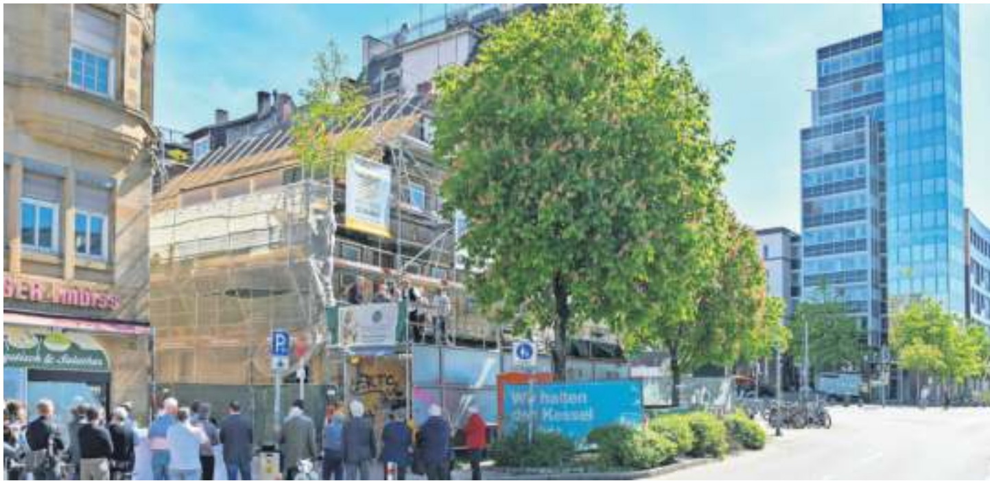
Vor zwei Wochen wurde an der Hauptstätter Straße Richtfest gefeiert.
