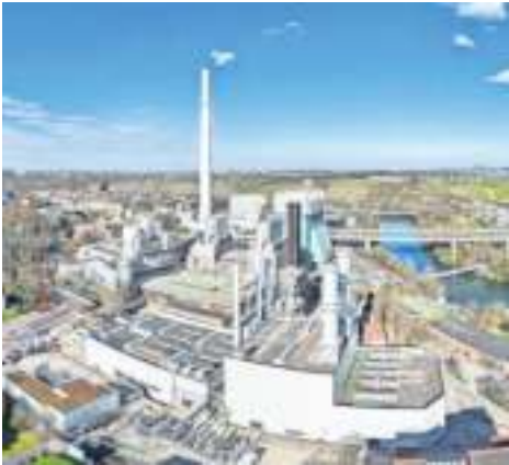
Das neue, wasserstofffähige Gasturbinenkraftwerk in Münster kann mit einer Leistung von 124 Megawatt Strom und 370 Megawatt Wärme flexibel gefahren werden. Foto: EnBW
