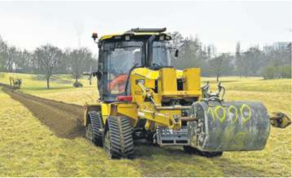
Die neue Leitung durch einen Grünbereich zwischen Max-Eyth-See und Neckar wurde mit einem Spezialbagger eingesetzt, der in der Lage war, einen nur 20 Zentimeter breiten Graben über die erforderlichen 200 Meter zu ziehen. Foto: Stuttgart Netze GmbH
