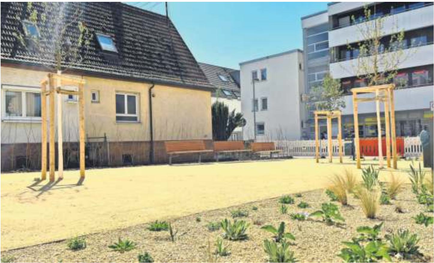
Der neue Quartiersplatz in der Hindenburgstraße in Nellingen hat einen Bodenbelag als „wassergebundene Decke“.
