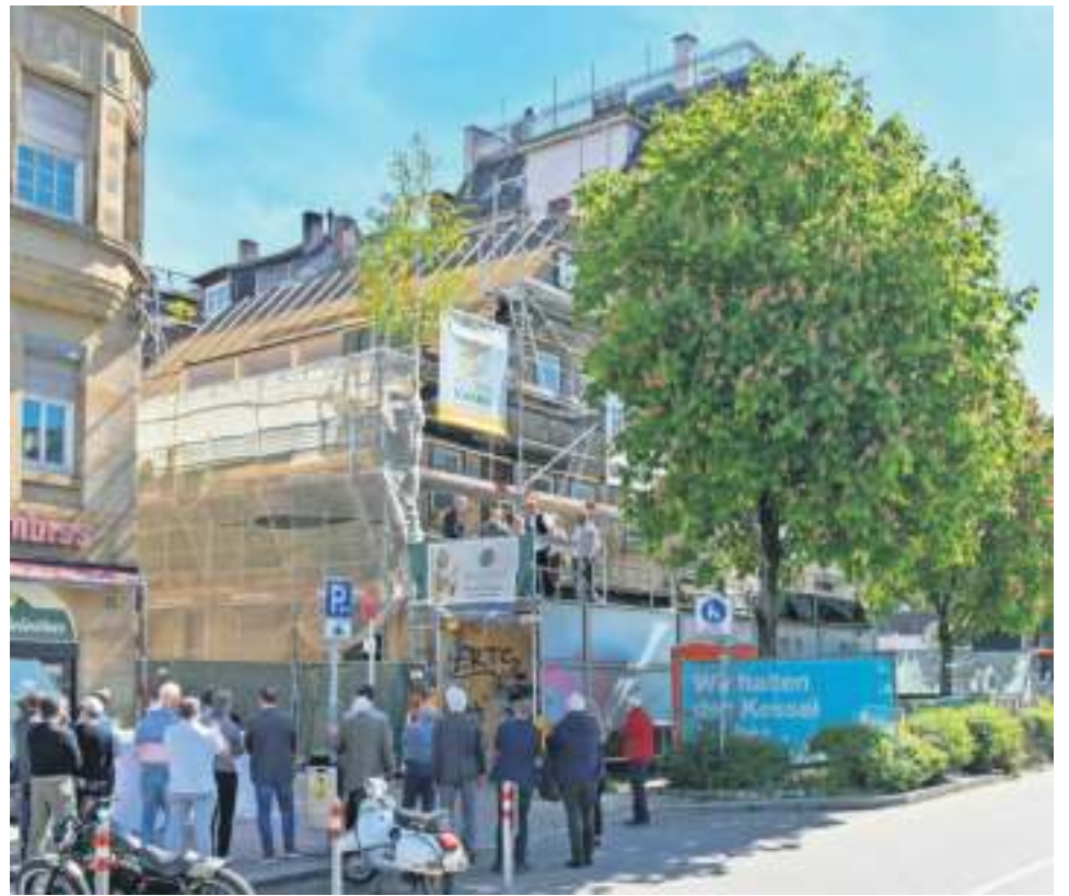
Vor zwei Wochen wurde Richtfest an der Hauptstätter Straße gefeiert.
