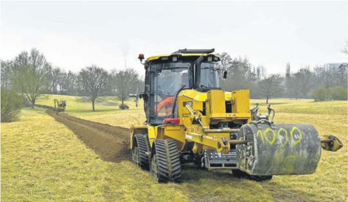
Die neue Leitung durch einen Grünbereich zwischen Max-Eyth-See und Neckar wurde mit einem Spezialbagger eingesetzt, der in der Lage war, einen nur 20 Zentimeter breiten Graben über die erforderlichen 200 Meter zu ziehen. Foto: Stuttgart Netze GmbH
