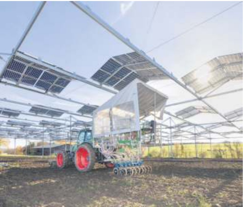
Unter der bis zu zehn Meter hohen Stelzenkonstruktion können branchenübliche Traktoren ohne Probleme hindurchfahren. Foto: Universität Hohenheim/Thomas Klink
