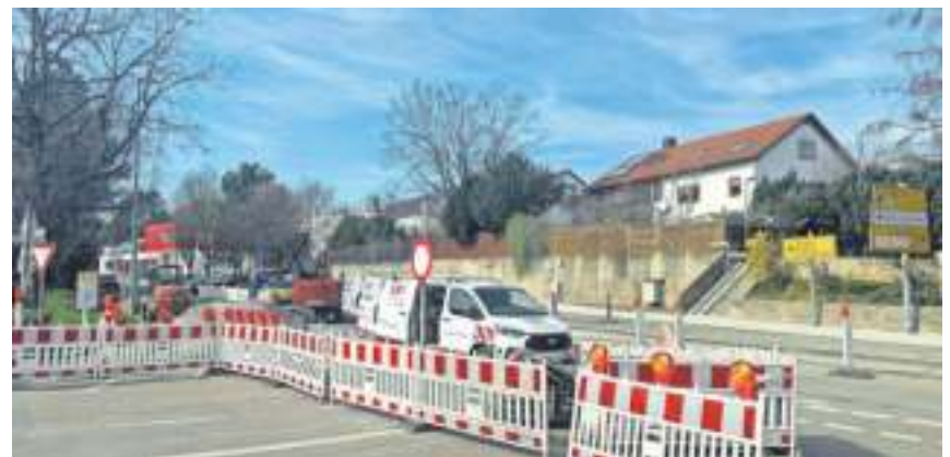
In der Gotthilf-Bayh-Straße startet der 3. Bauabschnitt.
