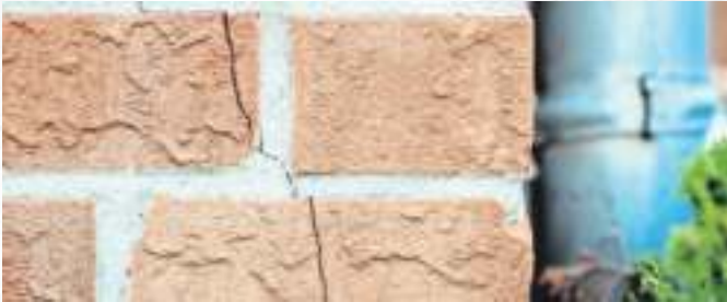
Frühjahrs-Check fürs Haus: Risse, Feuchtigkeit, Dach & Dämmung im Blick behalten.
