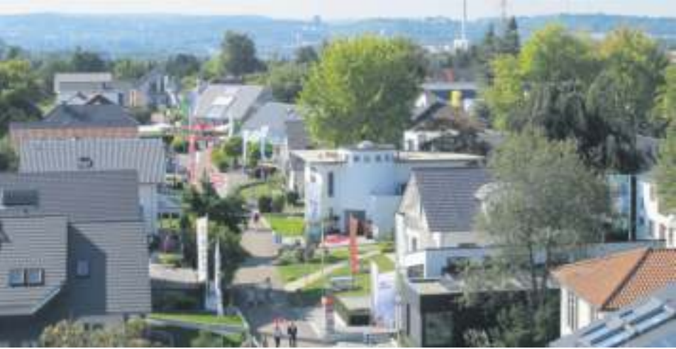
Die Musterhaussiedlung in Fellbach lädt zum „Baufrühling 2026“. Foto: z
