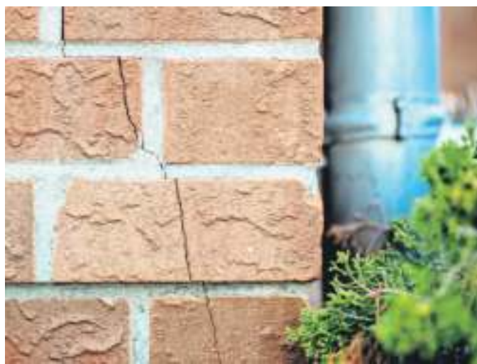
Frühjahrs-Check fürs Haus: Risse, Feuchtigkeit, Dach & Dämmung im Blick behalten.
