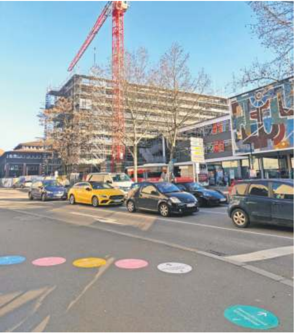
Mit bunten, runden Markierungen auf den Gehwegen werden Fußgänger am Alten Postplatz in Waiblingen zu den entsprechenden Ämtern der Kreisbehörde geleitet. Foto: Ingrid Sachsenmaier
