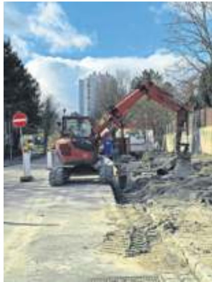
Die Bushaltestelle „Friedrichstraße“ wird barrierefrei. Foto: Özalp
