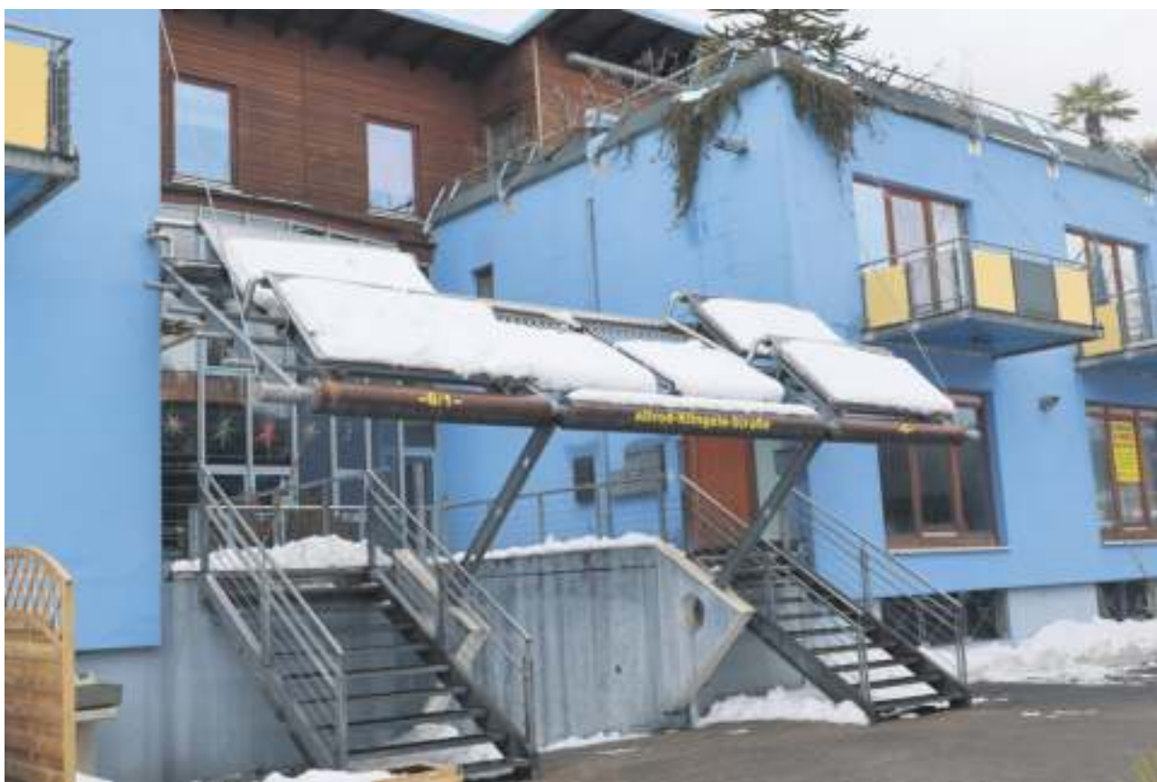
Das Gebäude von ICS Technik erreicht auch im Winter energetische Spitzenwerte – der Energieausweis unten beweist es.
