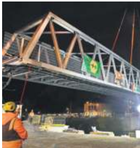
Das Einheben der neuen Behelfsbrücke: Das tonnenschwere Stahlteil führt nun über den Neckar.
