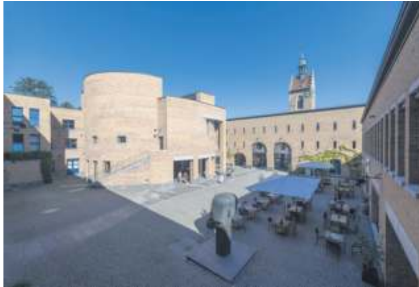
Das Brandschutzkonzept fürs Rathaus wird schrittweise umgesetzt. Foto: Hartung
