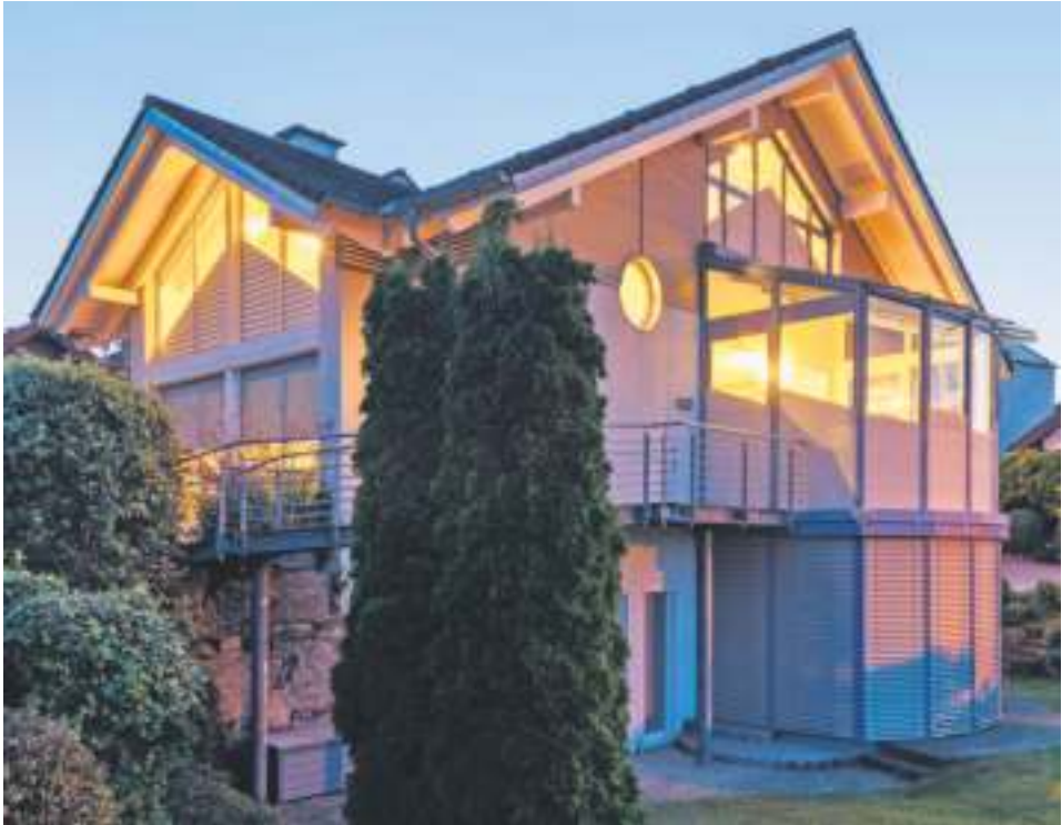
Ein hochwertiger Rollladen kann in der kalten Jahreszeit viel Heizenergie einsparen. Man sollte ihn daher stets bei Einbruch der Dunkelheit schließen.
