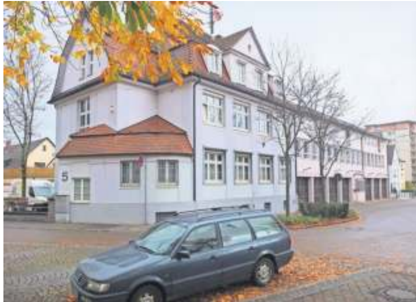
Bis zum Neubau an der Bühlstraße wird das Feuerwehrhaus in der Wiesenstraße ertüchtigt Foto: Knopp
