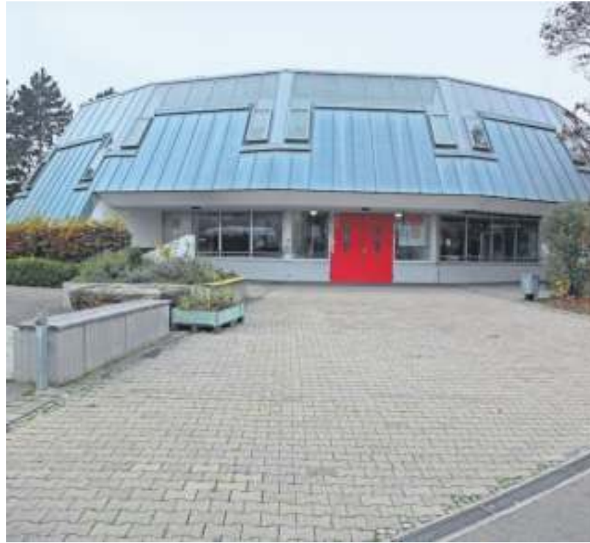
Der Brandschutz im Jugendhaus muss verbessert werden.
