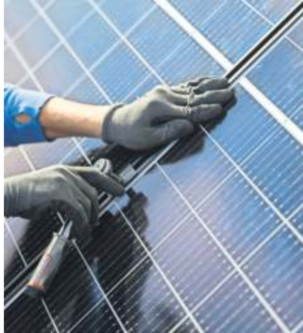
Bei der Installation von Solaranlagen kann es technische, bauliche und rechtliche Vorgaben geben. Foto: dpa
